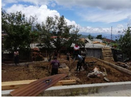
Para construir el módulo tiraron la cocina que estaba muy deteriorada con piso de tierra, con fogón en el suelo, las paredes de madera con arcilla; tiraron la casa vieja que utilizaban como gallinero. Donde estaba la cocina construyeron el módulo para producir hongo y donde estaba la casa vieja construyeron la cocina con piso firme de cemento con un fogón ecológico para prevenir enfermedades pulmonares por humo.
